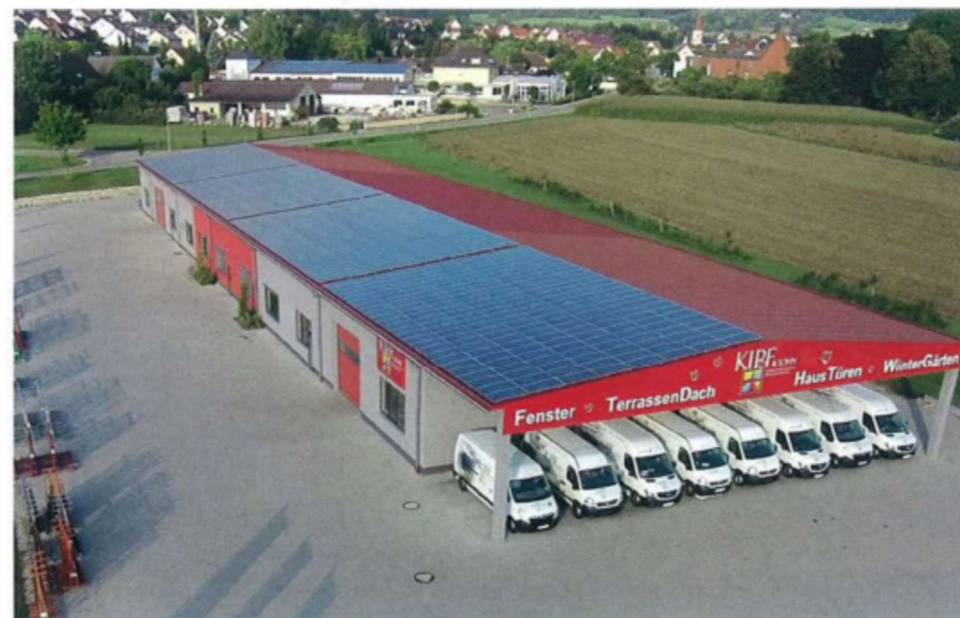
Die Fensterbau Kipf & Sohn GmbH setzt auf digitales Auftragsmanagement. Foto: Kipf
